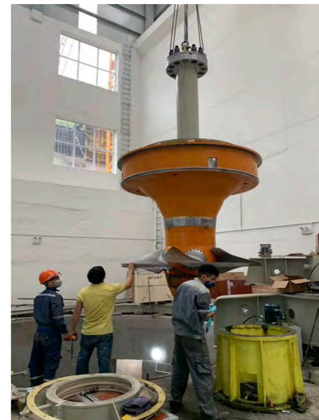
Hạ ROTOR và thả bánh xe Thủy điện Sông Nhiệm 4
